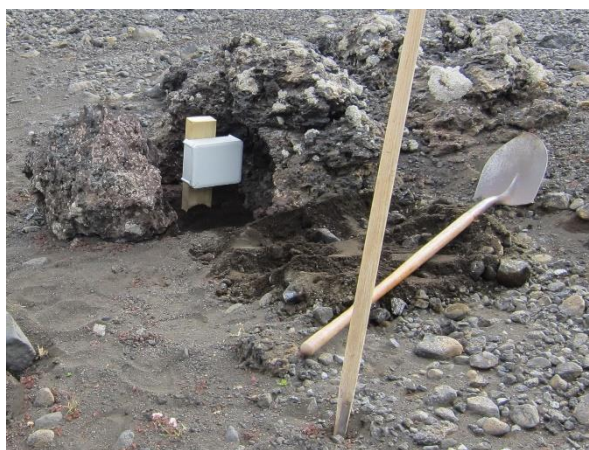
3. mynd. Bifreiðateljara komið fyrir í vegkanti.
