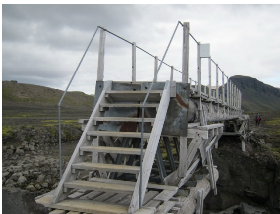
Mynd 4: Teljari á göngubrúnni yfir Kaldaklofskvísl.
