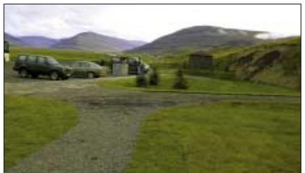
Í sumar var m.a. unnið að úrbótum við Hengifoss í Fljótsdal. Útbúið var bílastæði, komið upp salernisaðstöðu og gönguleiðin að fossinum stórbætt.
