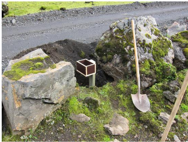
Mynd 11: Bifreiðateljara komið fyrir í vegkanti við Eldgjá.
