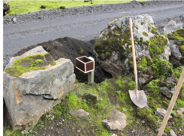
4. mynd. Bifreiðateljara komið fyrir í vegkanti.
