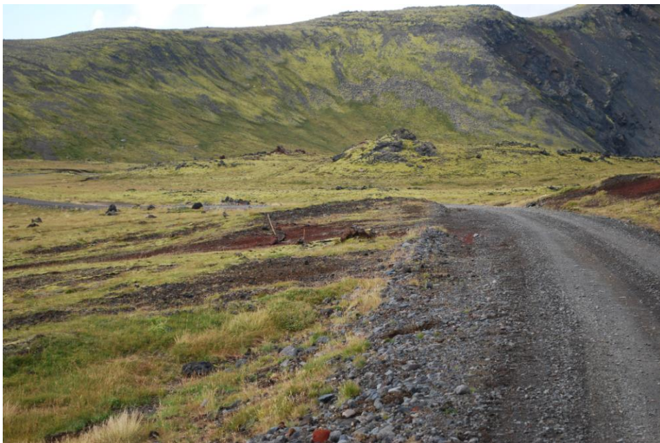
Mynd V 1.14 Rask og ummerki um framkvæmdir við veginn um Eysteinsdal
