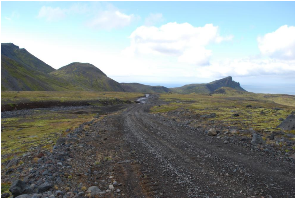
Mynd V 1.23 Við Móðulæk.
