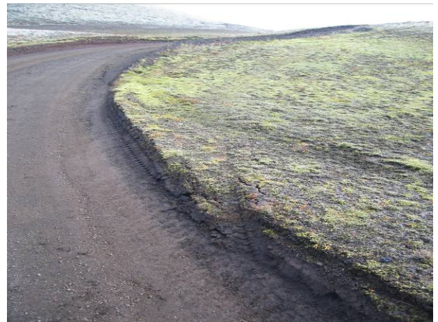
Mynd 17. Á einbreiðum vegum neyðast ferðamenn til að aka upp á vegkant þegar þeir mæta bíl
