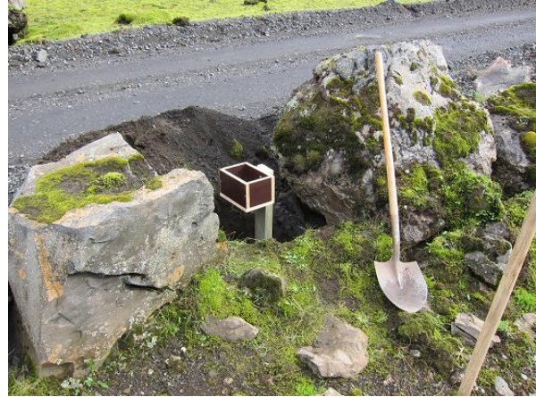
5. mynd. Bifreiðateljara komið fyrir í vegkanti.
